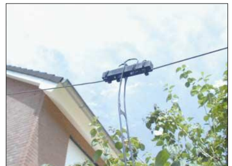
Bild 10: Ansicht des Mittenisolators und der symmetrischen Speiseleitung mit herausgetrennten Stegen
